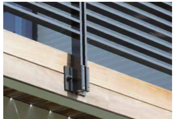
▲ Sapata FERIA para fixação em aplique (testa da laje)
